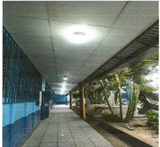
Foto 2: Mejoramiento de alumbrado corredor de aulas
