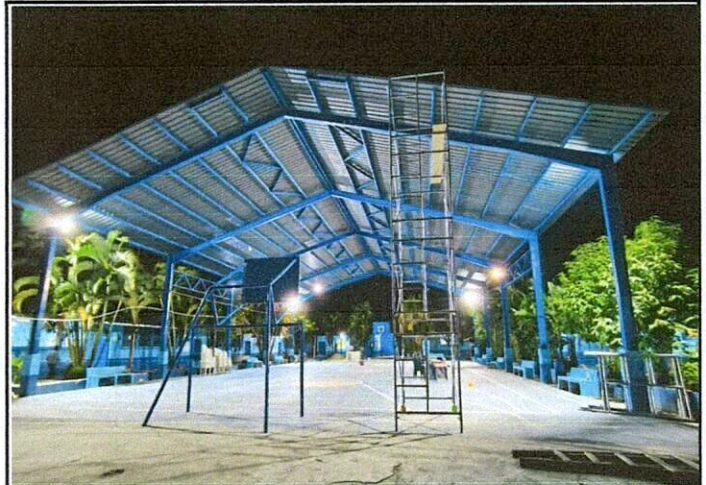
Foto 6: Mejoramiento de alumbrado reflectores en la cancha
