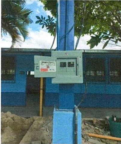
Foto 1: Mejoramiento de caja principal
